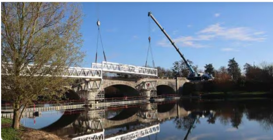
Installation des deux passerelles qui franchissent la Sarthe et son canal adjacent à Noyen-sur-Sarthe. | OUEST-FRANCE
