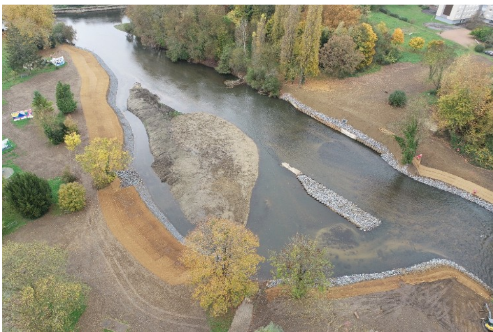
Fin des travaux de remise en état de l'Huisne au niveau du barrage des Bouches d'Huisne - Crédits photos : Le Mans Métropole
