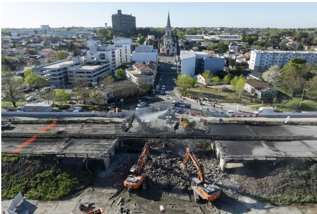
Travaux de réaménagement de la route de Pornic, suppression de l'autopont. Photo Nantes Métropole.
